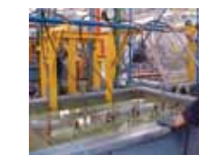
Prueba de fugas
