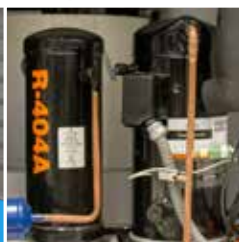
Compresor Scroll y acumulador de succión
