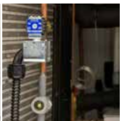
Válvula Solenoide y Mirilla
