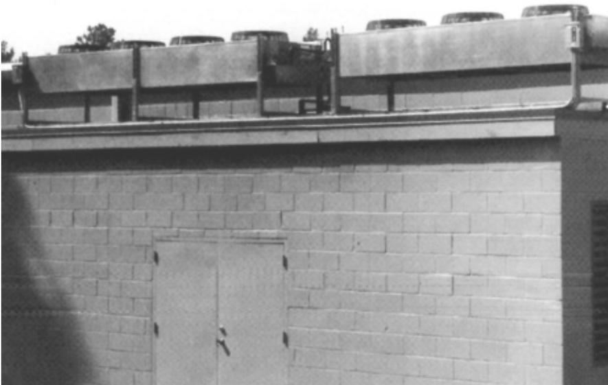
La aplicación en los supermercados típicamente usa condensadores múltiples enfriados por aire los cuales son conectados con tubería hacia el cuarto de máquinas. El personal de mantenimiento debe poner atención especial al control de los ajustes de tal manera que el ciclaje corto del ventilador pueda prevenirse.
